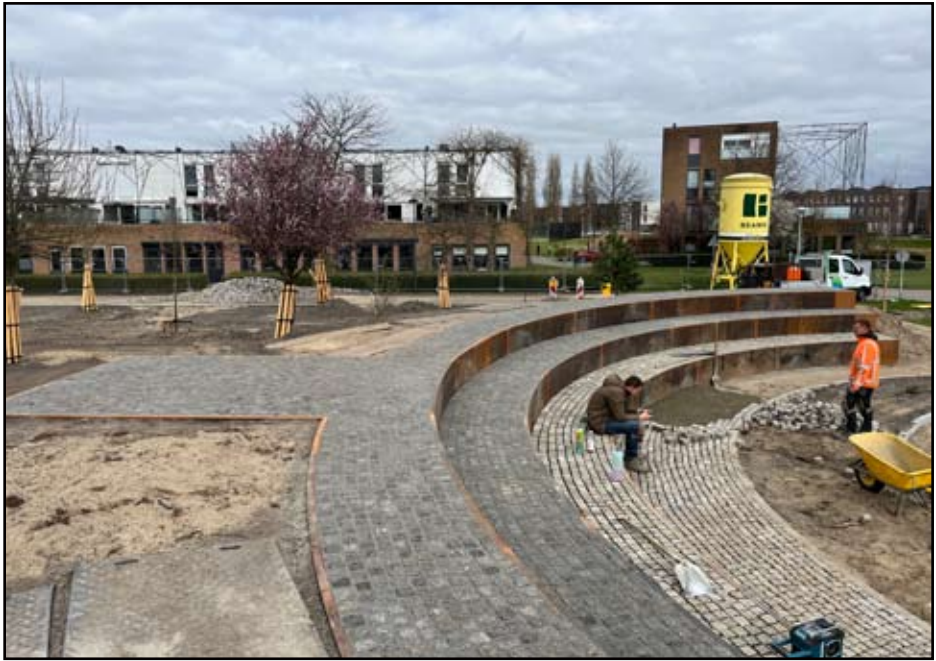
De Portugese keitjes worden gesteld in zandcement. Rechts voor het invoegen en links na het invoegen.
