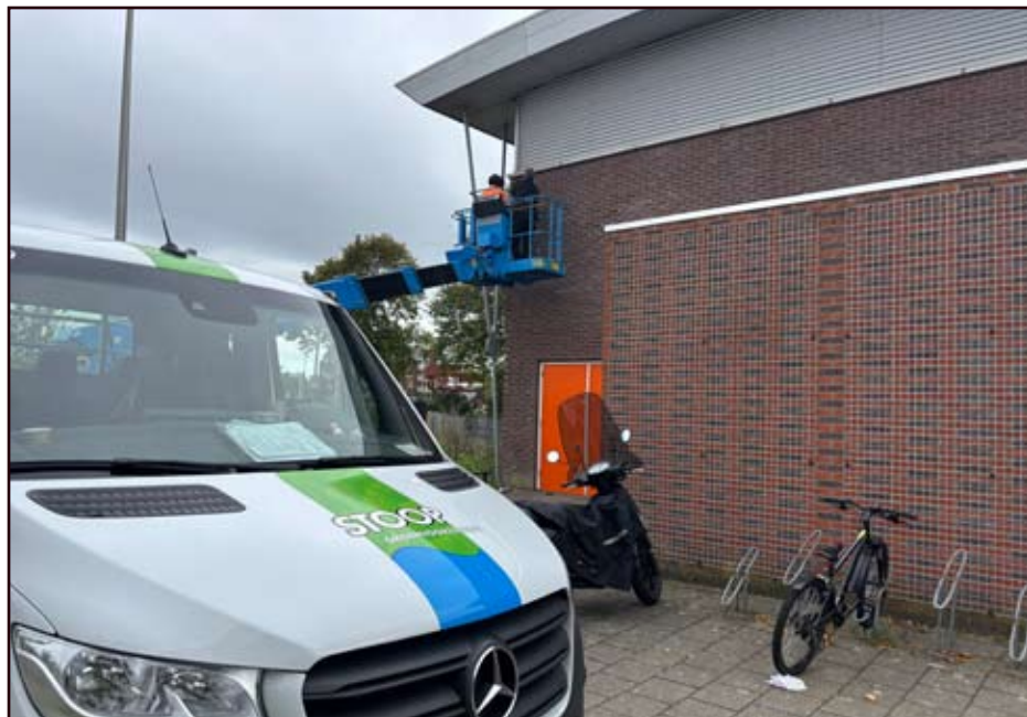
Het spankabelsysteem wordt geplaatst.
