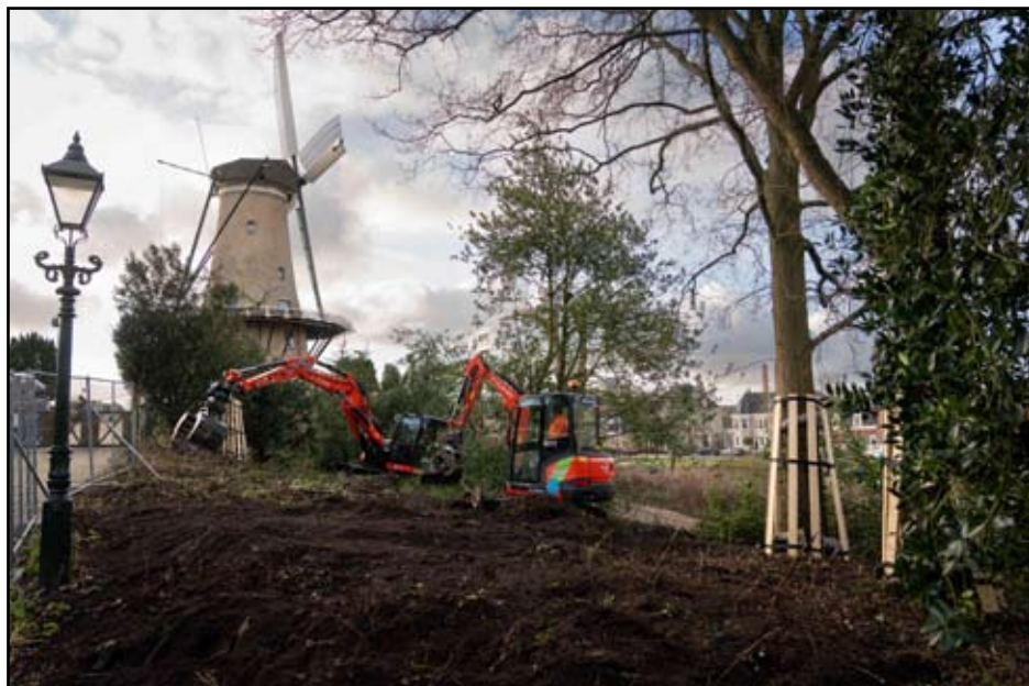
Het rooien van de beplanting, waarbij de minikraan de lastig bereikbare delen onder te handhaven bomen rooit.
