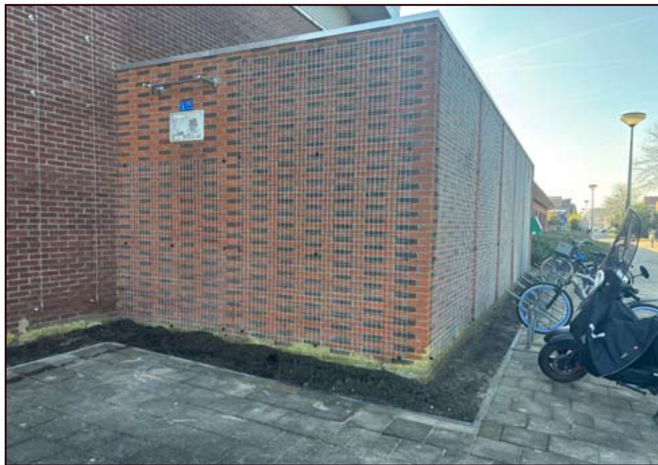
De gaspanelen hangen en de plantsleuf ligt klaar.
