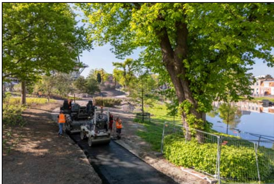
Het nieuwe asfaltpad wordt aangebracht medio mei.
