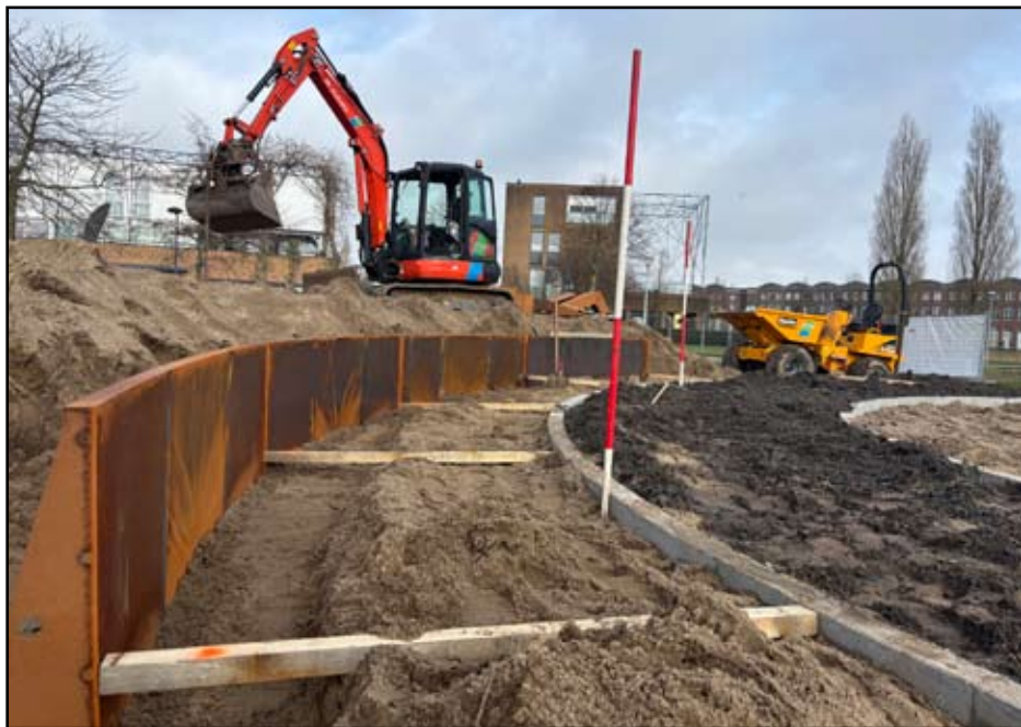
De cortenstalen elementen van het Amfitheater stellen.
