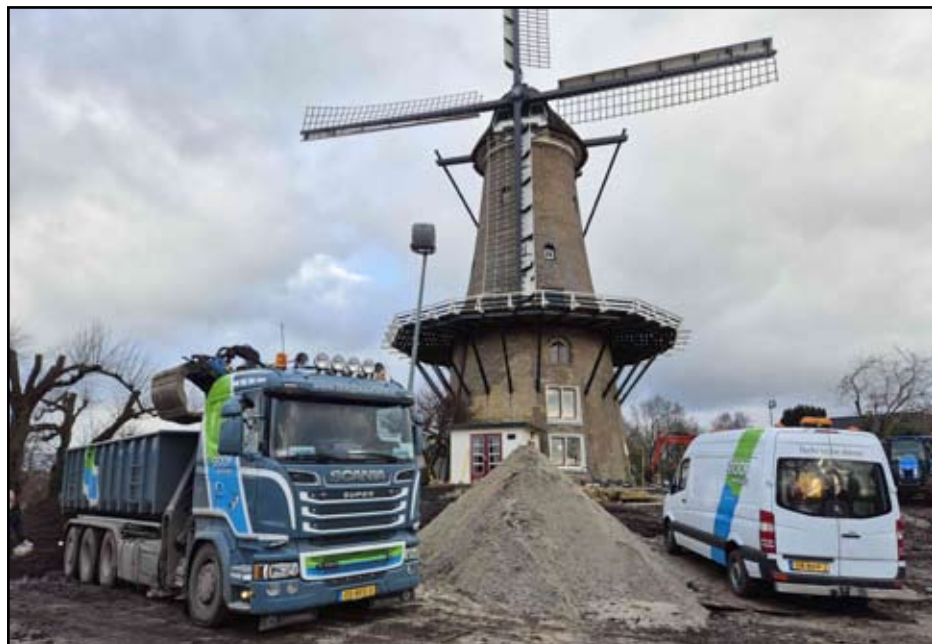
Vrachtauto's konden het werkgebied bereiken via een stijle opgang langs de in- en uitgang van de Singelgarage.
