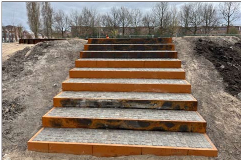
De trap naar het Amfitheater opgebouwd uit elementen van cortenstaal, ingelegd met hergebruikt Portugees graniet en gevoegd met epoxy voegmiddel.
