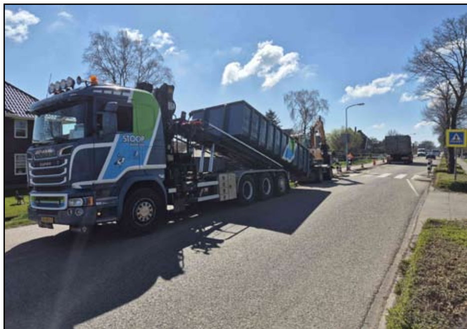
Ontgraven en afvoeren vrijkomende grond.
