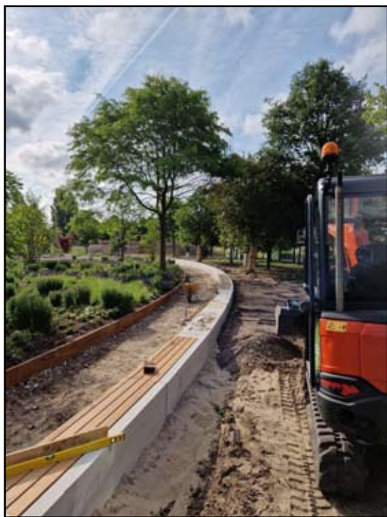
Het stellen van de keermuur/zitelementen met houten latten. Links de vaste planten die er al prachtig bij staan.
