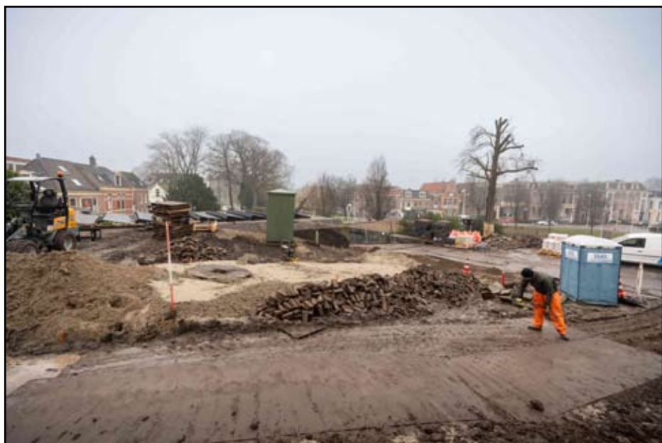
Het grondwerk is in volle gang.
