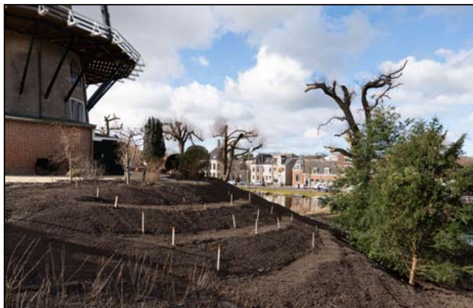
Het geprofileerde talud waarin de trappen van de nieuwe hagen goed te zien zijn uitgezet met piketpalen.
