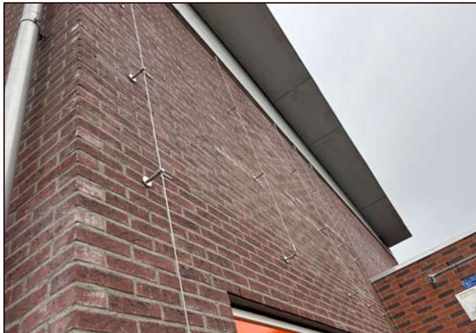
Het spankabelsysteem, vooraf aan het aanplanten.
