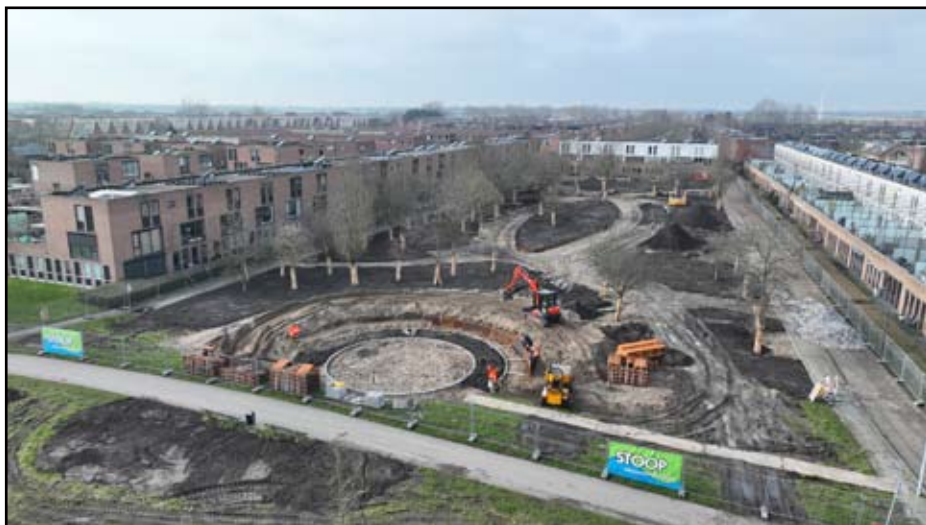
Op de voorgrond het Amfitheater in aanbouw. In het midden de centrale border omrand door cortenstaal. Rechts het grondlichaam in opbouw. De plantvakken zijn voorzien van teelaarde en Green to Colour.
