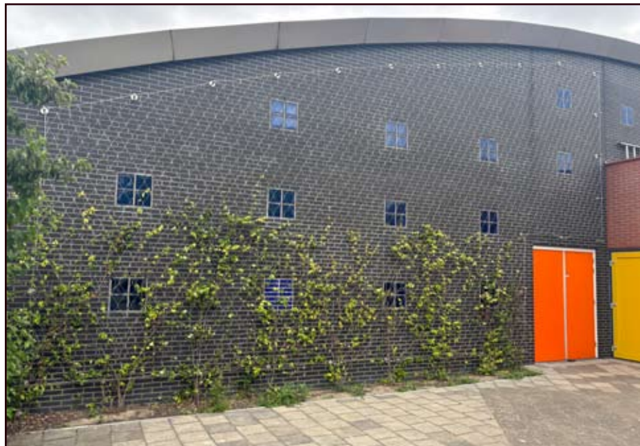
Het kabelnet hangt, en de jonge beplanting kan zijn gang gaan.
