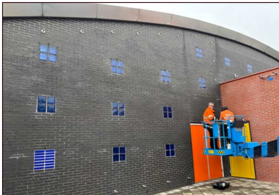
Erwin Dekker en Patrick Raymond bevestigen de ankerpunten voor het kabelnet.
