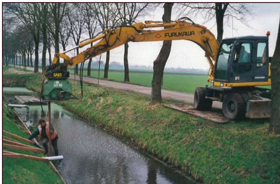
Beschoeiing zetten kantoortuin. Jos van Stralen en Bines Bakker. 2001.
