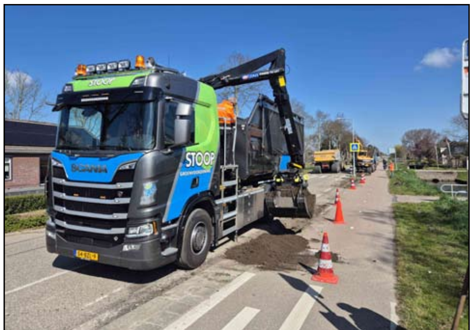
Gert vult grond aan met zijn nieuwe vrachtauto met kraanbediening.
