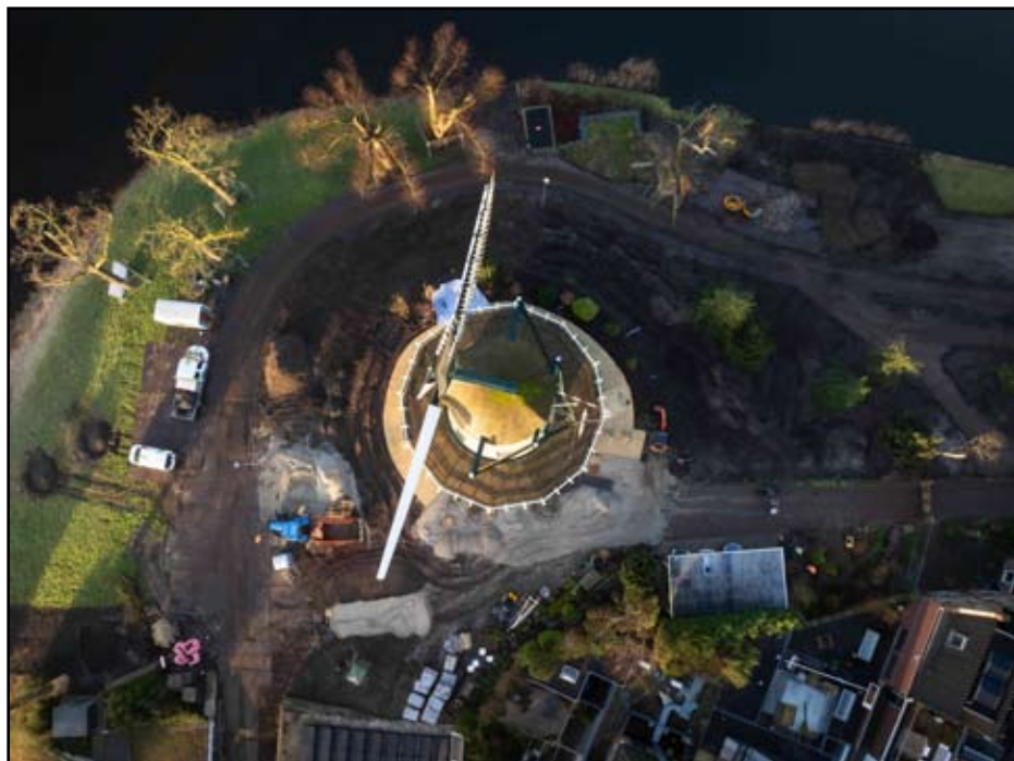
Een luchtfoto terwijl het grondwerk vordert.
