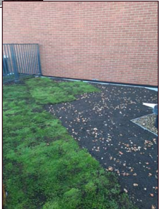
De aangeplante bollen zijn nog zichtbaar voor het aanbrengen van het Sedumtapijt.
