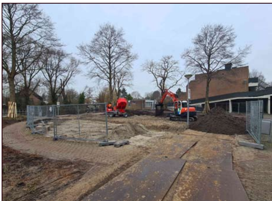
De grondwerkzaamheden in volle gang.
