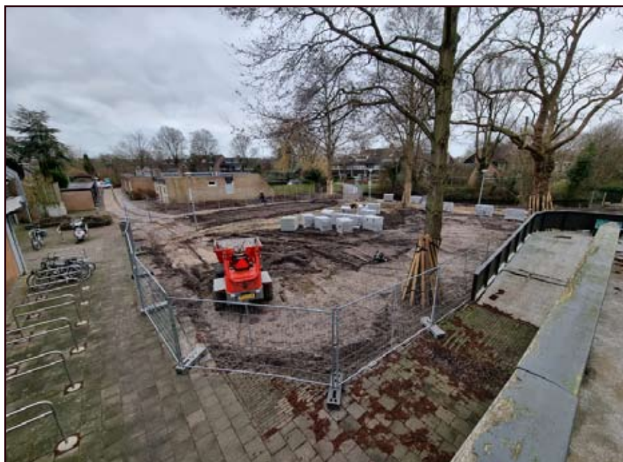
De eerste straatwerkzaamheden worden voorbereid.
