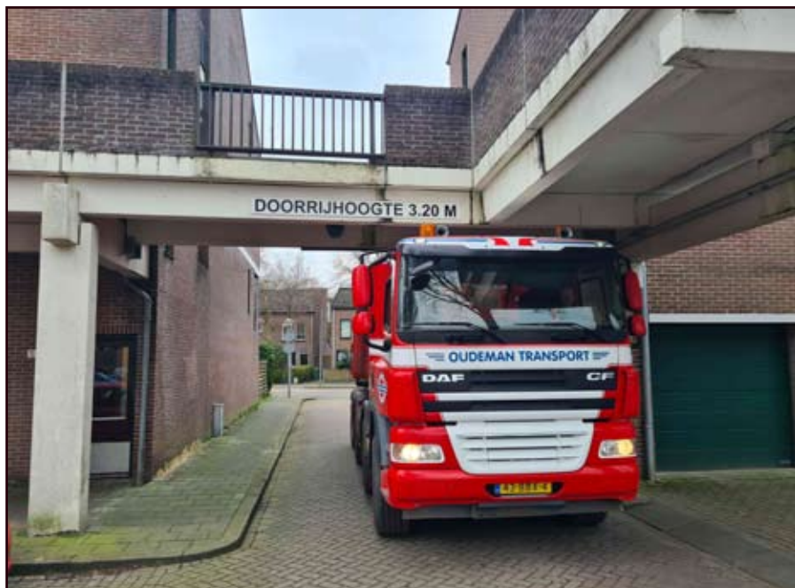
De hoogtebeperking zorgde voor een aangepaste aanpak in het grondwerk.
