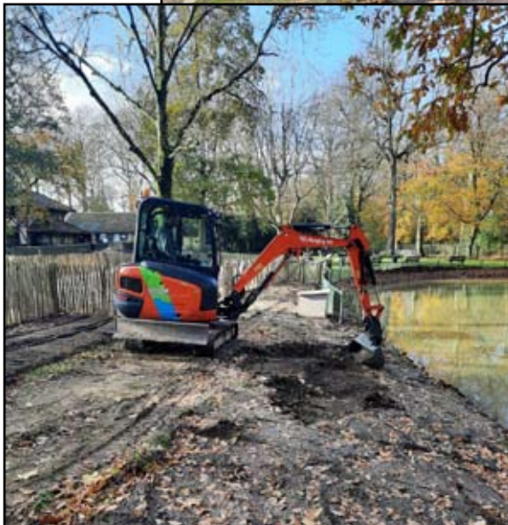
Het terrein tussen het ontdekkingspad en de watergang wordt geprofileerd.
