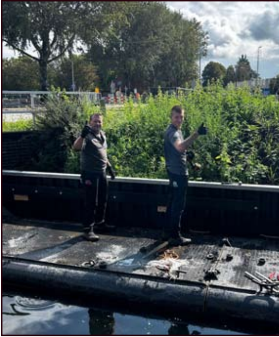
Foto ingezonden door Rick van Esch op 8 september: Frank en Teun bezig met het aanbrengen van ankers bij de beschoeiing in Uitgeest.
