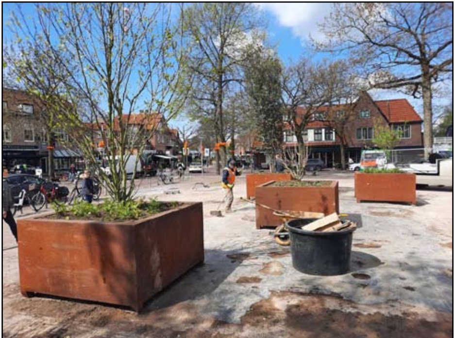
Plantenbakken plaatsen en aanplanten.
