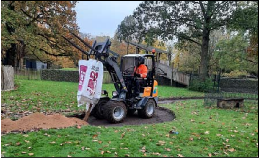
De Komex wordt met de minishovel verwerkt vanuit een big-bag.
