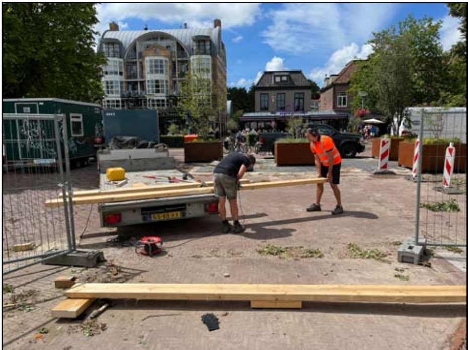
Frank en Edwin zijn bezig met de balklaag van het vlonder.
