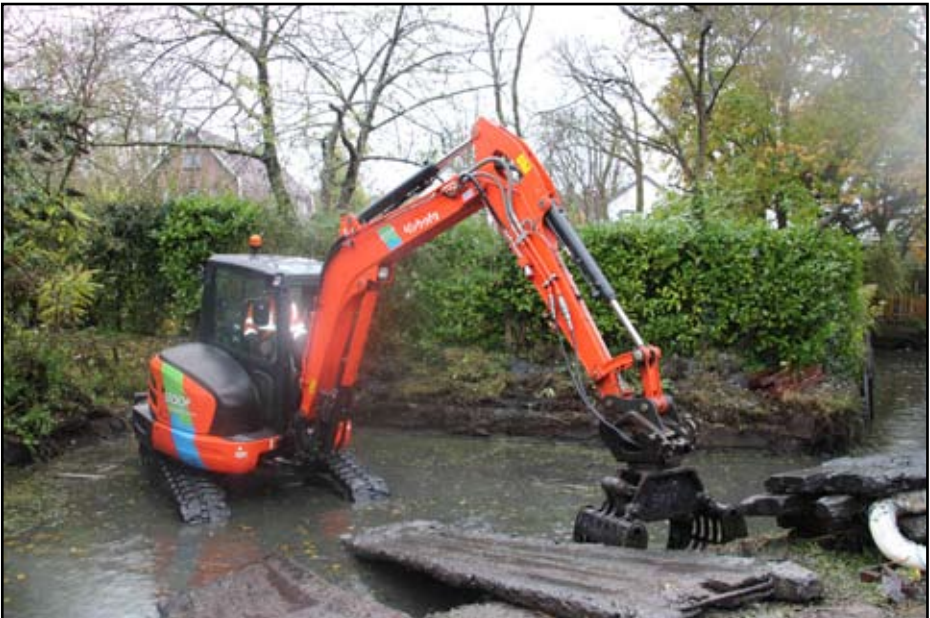
Waar mogelijk wordt op een creatieve manier nog gebruik gemaakt van een mini-kraan.
