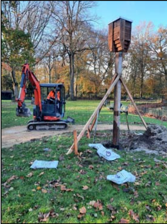
De vleermuiskast met paal wordt geplaatst met betrekking tot tijdelijke schoorpalen.
