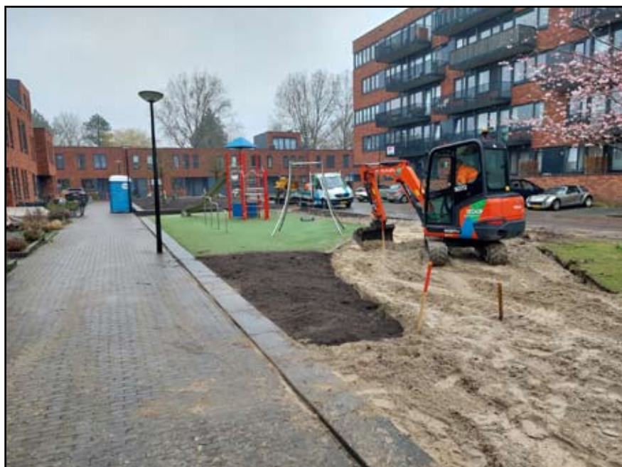
Grondwerk voor nieuwe plantvakken en een halfverhardingspad.
