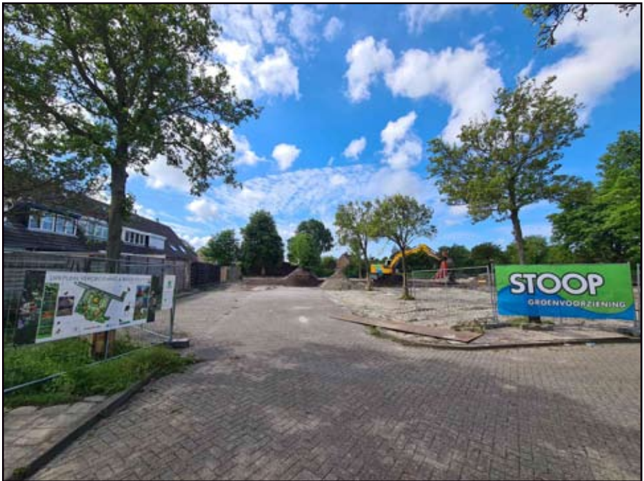
Het rooien van de beplantingen en verhardingen.
