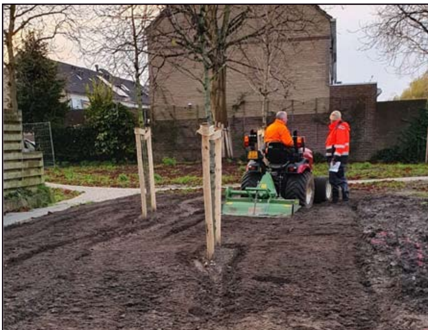
Het frezen van het terrein voor aanvang van het bollen planten.
