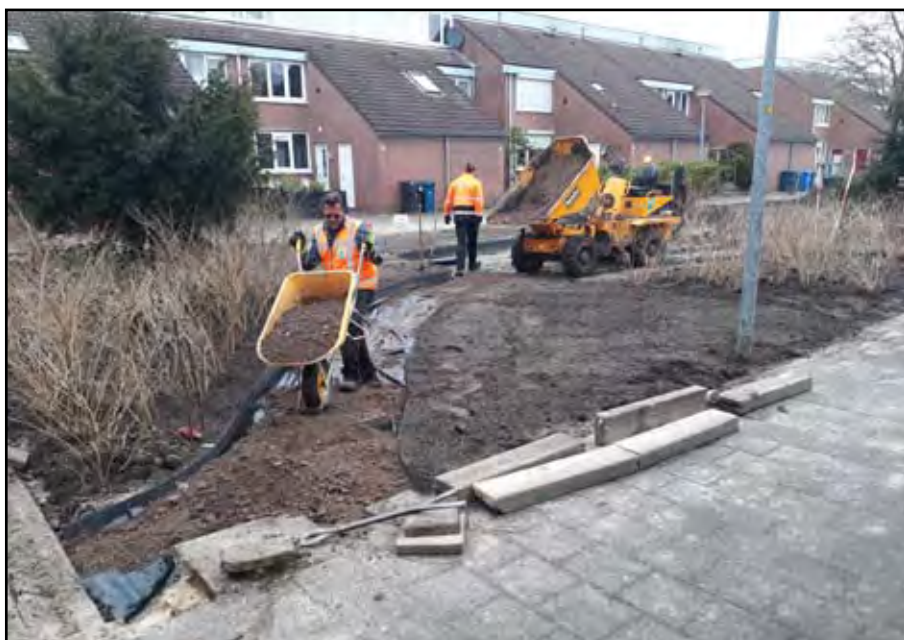
Het deel handmatig aanbrengen van het halfverhardingspad.
