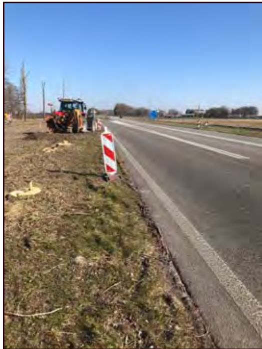
De stobben worden uitgefreesd. Op de achtergrond de gekandelabende populieren voor de vleermuizen.
