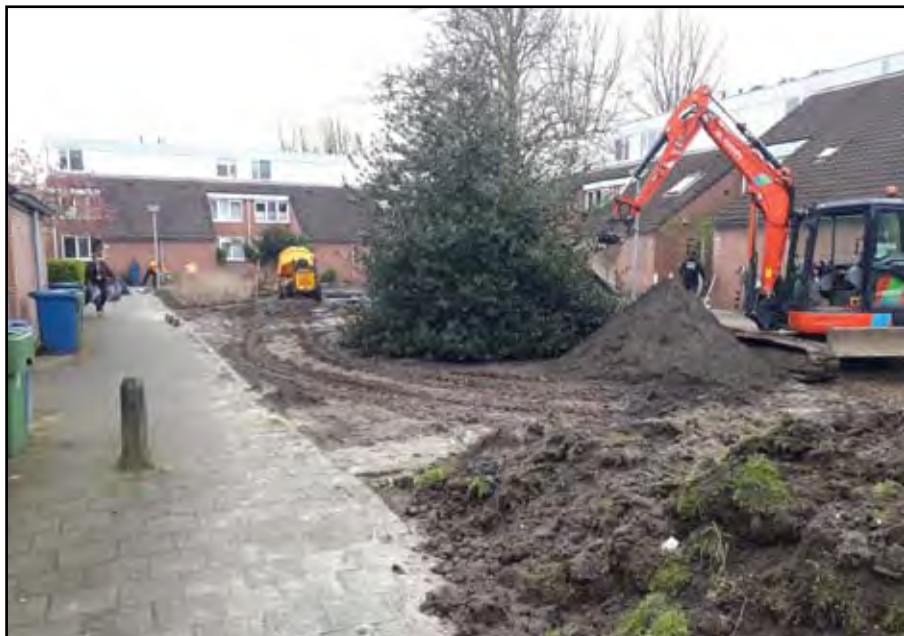
Nadat de beplanting is gerooid en opgenomen wordt het grondwerk uitgevoerd.
