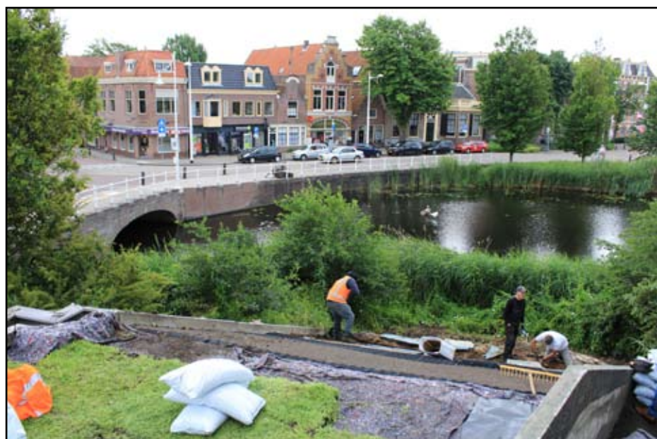
Werken op het schuine deel was een uitdaging.
