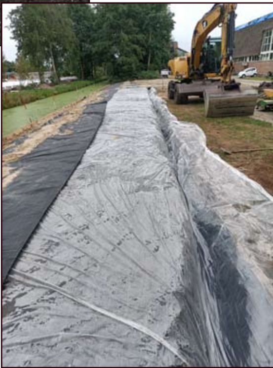
Het zuurstofdichte folie en het antiworteldoek worden aangebracht.
