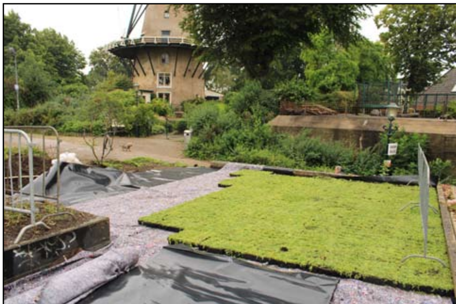
Het vlakke deel waarbij de opbouw van materialen goed is te zien.
