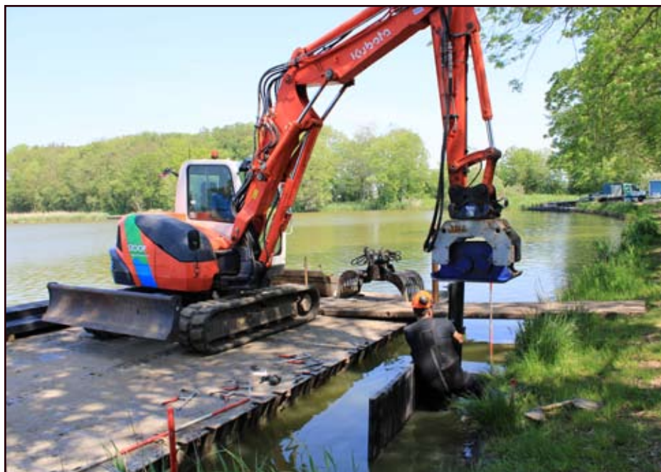
Aanbrengen kunststof damwandplanken voor nieuwe visplek
