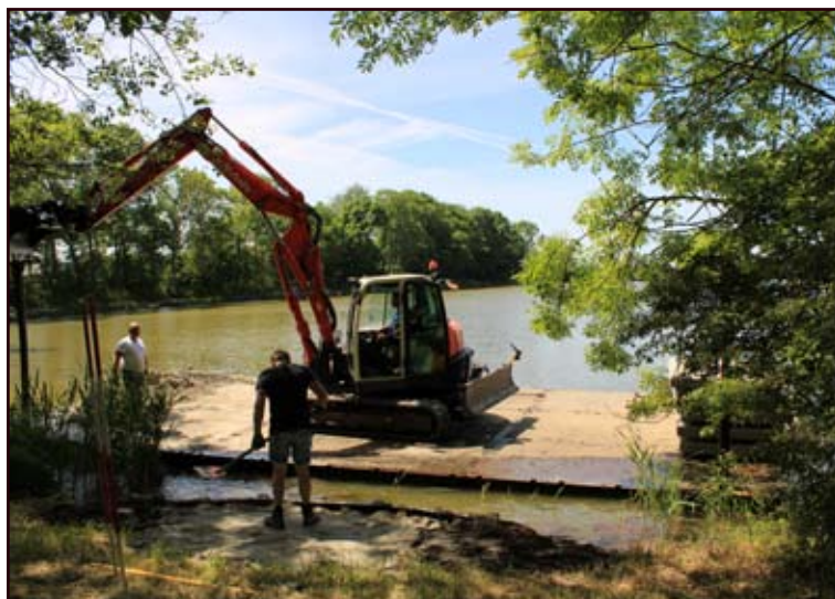
Zand en stelconplaten op het ponton.
