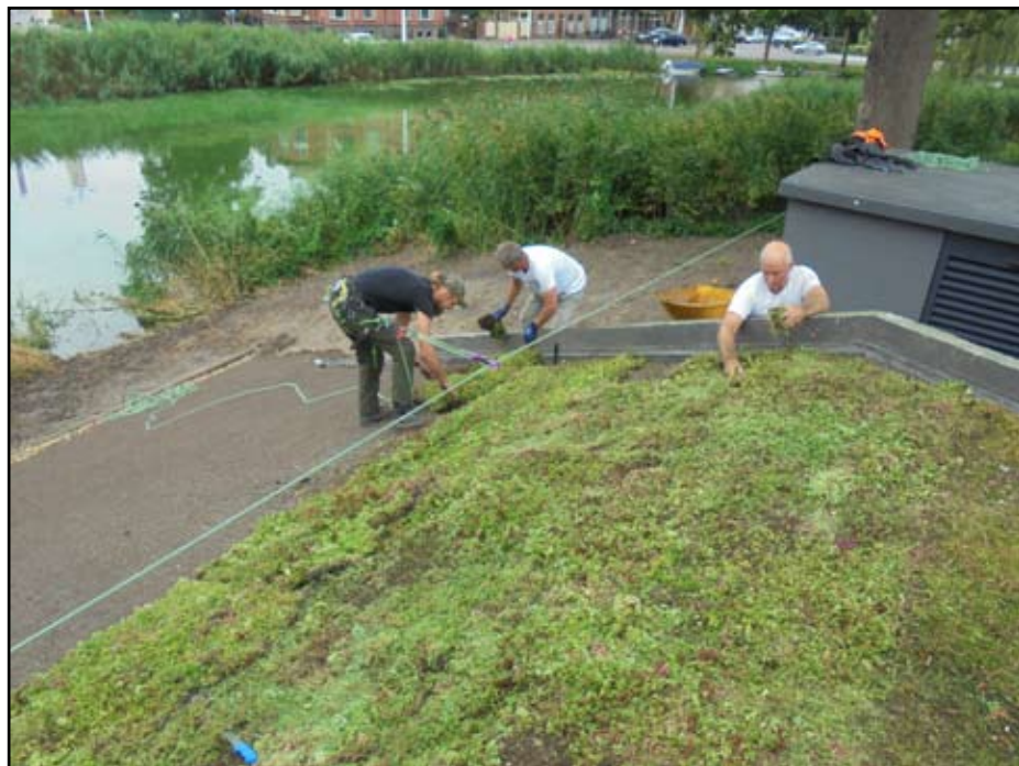
Het aanbrengen van de nieuwe sedummatten met behulp van een creatieve valbeveiliging.
