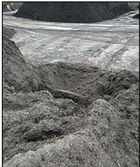
Aanvulgrond met een krater waar regenwater in kan blijven staan.
