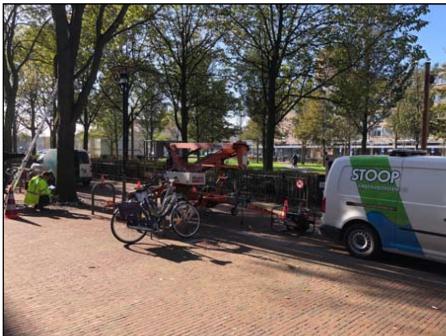
Vorbereidingen treffen op het drukke Julianaplein.
