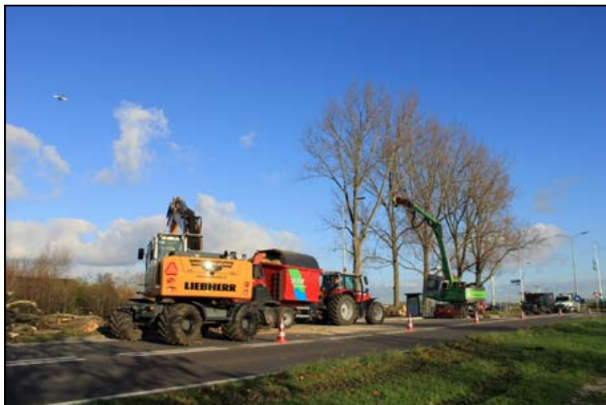
De wielkraan met lange giek, houtklem en zaagkast in actie.
