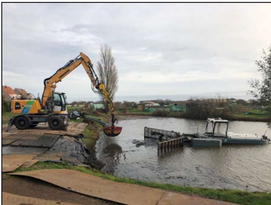
De schuifboot geassisteerd door de wielkraan.
