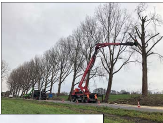
De telekraan met houtklem en zaagkast in actie.
