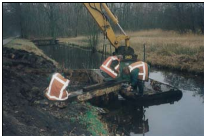
Aad Huyberts, Jos van Stralen en Marc van Stralen. Landhoofden aanbrengen, Amsterdamse Bos 1999.
