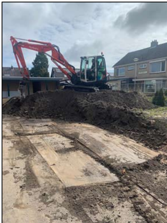
Grondwerk in de achtertuin.
